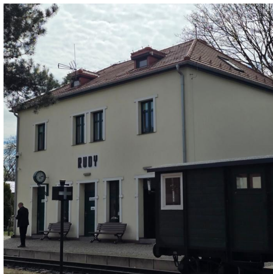
Fotografia 13. Widok na budynek rekonstrukcji dworca
