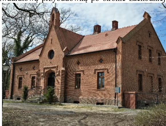
Fotografia 5. Widok na budynek szpitala w Rudach
